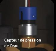
Des **capteurs** surveillent la pression du réfrigérant et de l'eau pour détecter les fuites.
