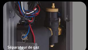
L'unité extérieure dispose d'une **fonction de purge forcée**. Le **séparateur de gaz** dans les conduits hydrauliques permet d'éviter les fuites de gaz à l'intérieur du logement.
