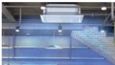
Mantenimento e uniformità della temperatura con la modalità "WindFree™" per evitare getti d'aria diretti grazie ai 15.700 microfori.
